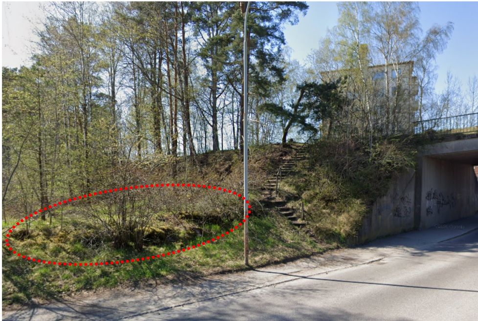
Figur 3 Järnvägsbro med tillhörande vingmurar
