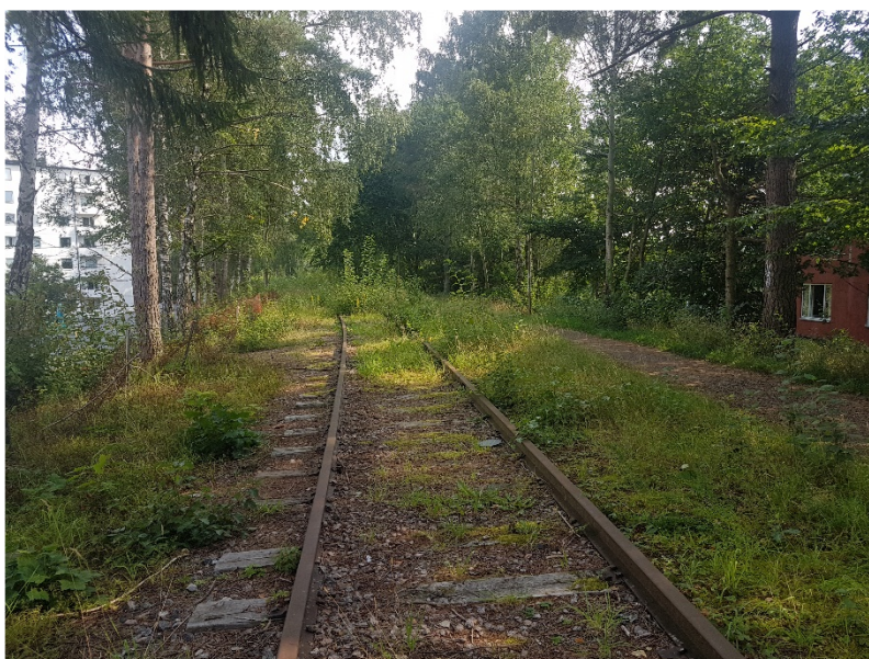
Figur 2. Järnvägsbanken i den norra delen
