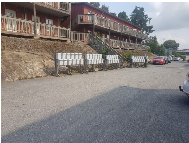
Figur 1. Befintliga byggnader inom området
